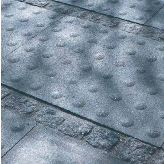
Eksempel på skift i belægning/ opmærksomhedsfelt
